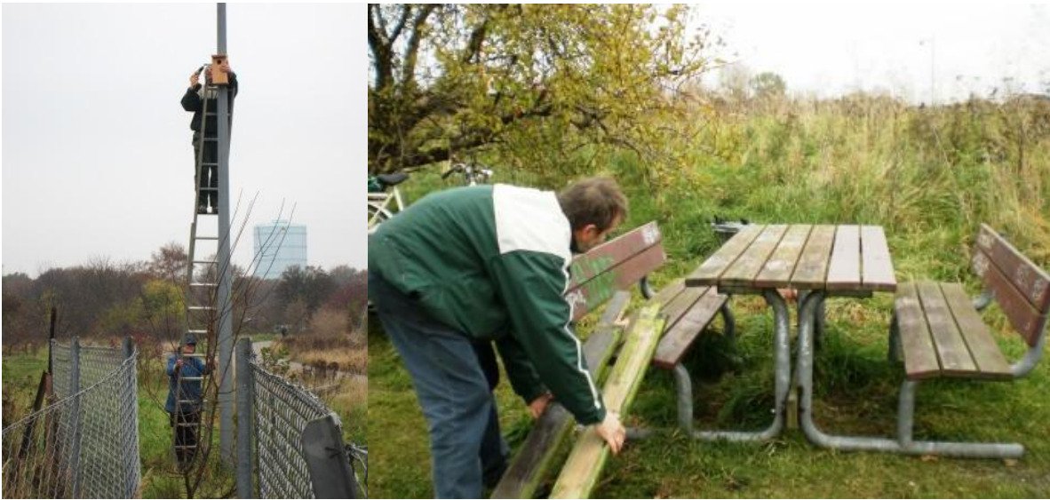
Opsætning af stærekasser og reparation af borde/bænke.
