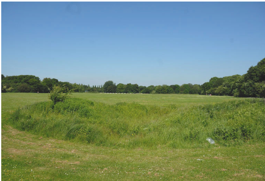
Figur 6-12 Udtørret vandhul (utæt lermembran) i Valbyparken
