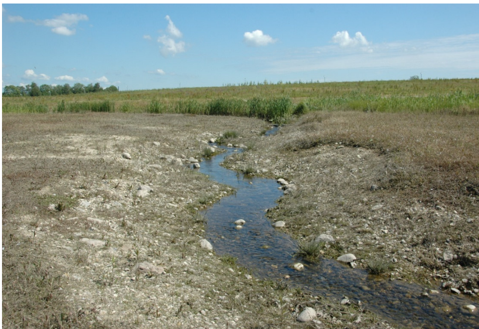
Figur 7-3 Eksempel på et ca. 2 år gammelt varieret vandløbsprofil fra Langagergårdområdet i Greve Kommune ved lille vandføring. Ved større afstrømninger fyldes hele vandløbsprofilen ud (op til der hvor vegetationen begynder).
