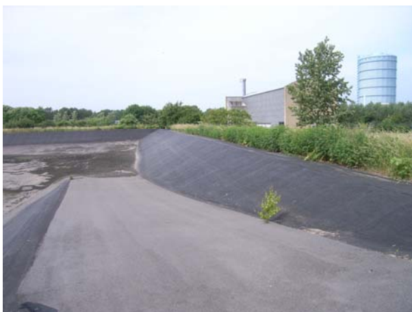
Figur 27. Teknisk bassin på Damhusåens Renseanlæg (2.1).
