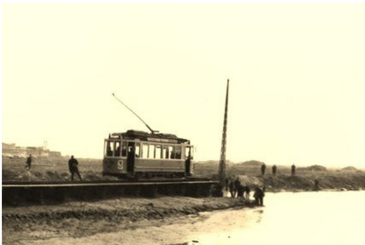
Billede nr. 3. Afbrænding af sporvogne for enden af Pumpehusvej 1967-72 (ukendt årstal).
